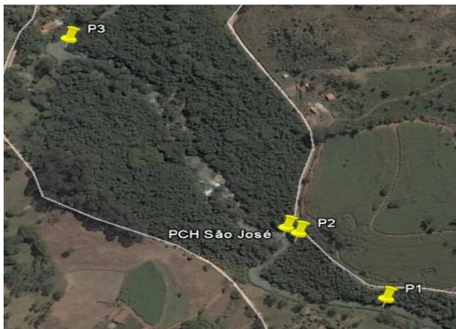
Figura 1 – Ponto 1, à montante da PCH São José; ponto 2, na área da PCH de São José; e ponto 3, à jusante da PCH de São José.
